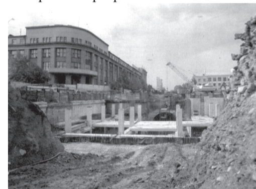
Строительство станции метро "Площадь 1905 года"
